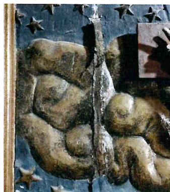
Calicot partiellement décollé, panneau central
