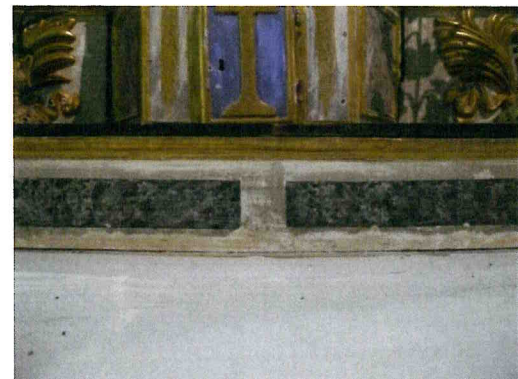
Partie centrale gradin
